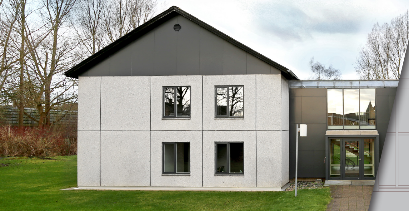
Bane-kollegiet er totalrenoveret i 2019
